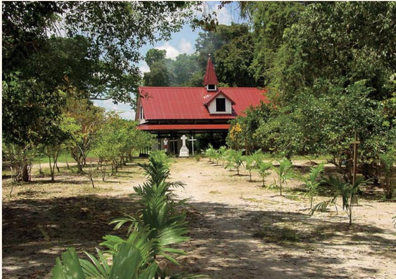
De tegenwoordige open bedevaartskapel. Philip Dikland ontwierp de kapel in 1997. In 2001 werd hij gebouwd en ingewijd. Het had aanvankelijk een vloer van schelpen. Al snel huisden daar echter sika's, een vilein soort zandvlooiën. Kerkgangers durfden de ruimte niet te betreden. Er is nu beton gestort. De dakvorm verwijst naar de 19de-eeuwse voorganger
