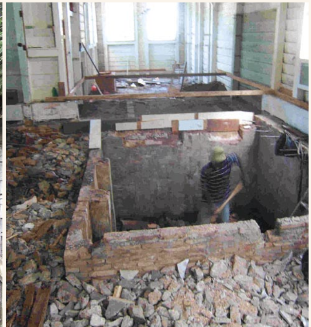
Waterkelder Henck Arronstraat 10 | Foto: S. Fokké / A. Lamur
